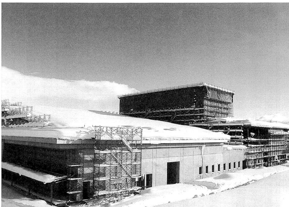
新博物館建設工事現場（平成13年1月26日）
