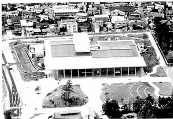
完成後の航空写真
